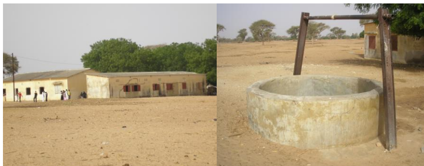
Photo 10 : CEM de Ngoye non clôturé ; puits pour l'approvisionnement en eau
